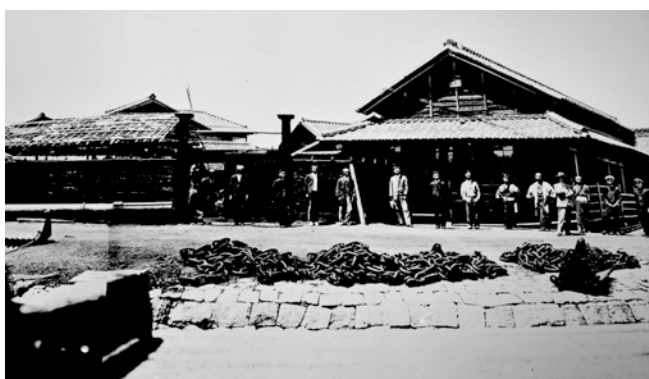
⑫若築建設所蔵 明治23～25年頃 旧本社写真(部分) →石垣のカーブ等の位置関係から見て、明治25年埋立範囲図と昭和4年「一般平面図(見取図)」の「X地点」付近から撮影か。 →第1期埋立工事の記念か。 →年代不詳であるが、若築建設史料群の中に、この写真に写る旧本社社屋と道路を描いた簡易図面が確認され、そこには本社と記されていることから、写真右側に写る長屋建物が旧本社社屋であろう。 →明治から昭和初期にかけて、社用地が分割されたことを示している。
