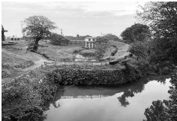
写真6 石井樋の井樋門（北から） ※手前が井樋門、奥が現代の水門
