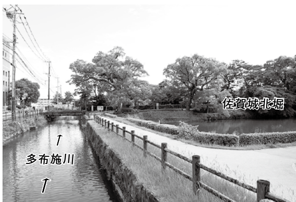
写真10 多布施川水路と佐賀城北堀の 立体交差点（北から）
