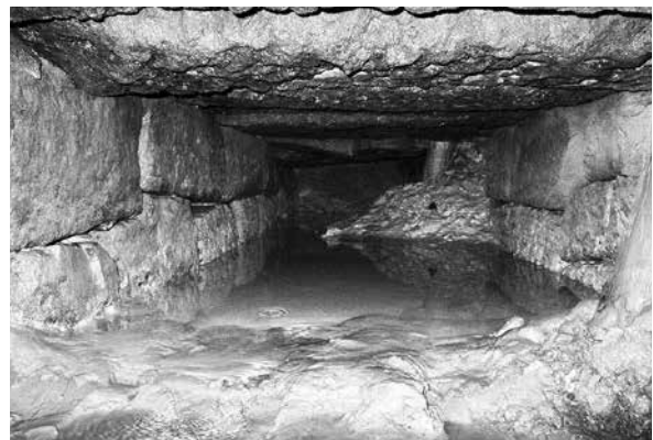
写真17 A地点 水場遺構S44 西壁暗渠の内部（東から） (佐賀城本丸歴史館2021『佐賀城本丸跡』PL. 11-3を転載)
